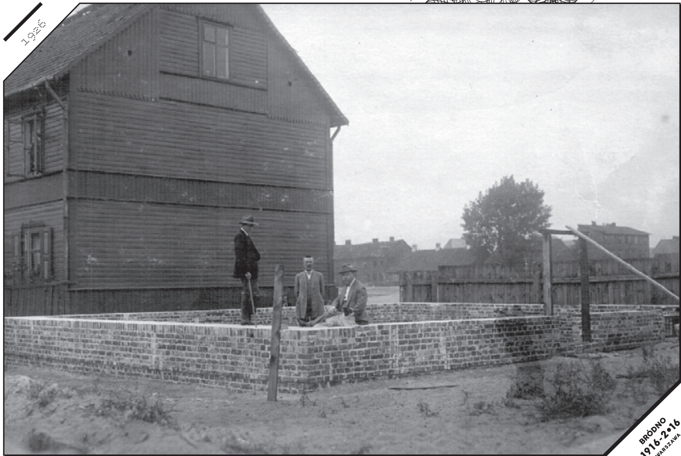
Ulica Julianowska 22, na pierwszym planie fundamenty budynku przy ulicy Julianowskiej 24.
